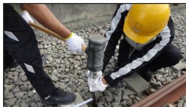
打設杭打ち込み
