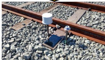
測定機器取付・測定
